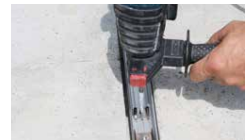
07 Bei Verputz-Variante die Montage des Einlegeprofils vorbereiten (Befestigungslöcher bohren)
