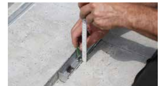
08 Bei Verputz-Variante die Höhe des Einlegeprofils für entsprechende Verputzschichtdicke justieren
