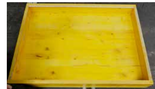
05 Ausschalen Bei der Verputz-Variante das Einlegeholz entfernen
